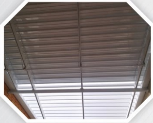
Sistema deslizante com rodízios em nylon que dispensa lubrificação
